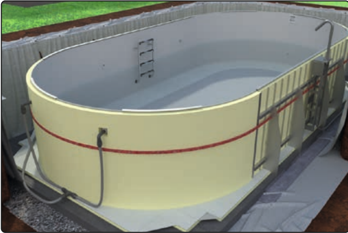
Becken bis auf 60 cm Höhe befüllen
