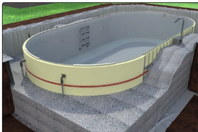
Kies gleichmäßig in der Baugrube einbringen
