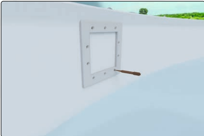
Lochbild nach dem Innenflansch anzeichnen und vorstechen
