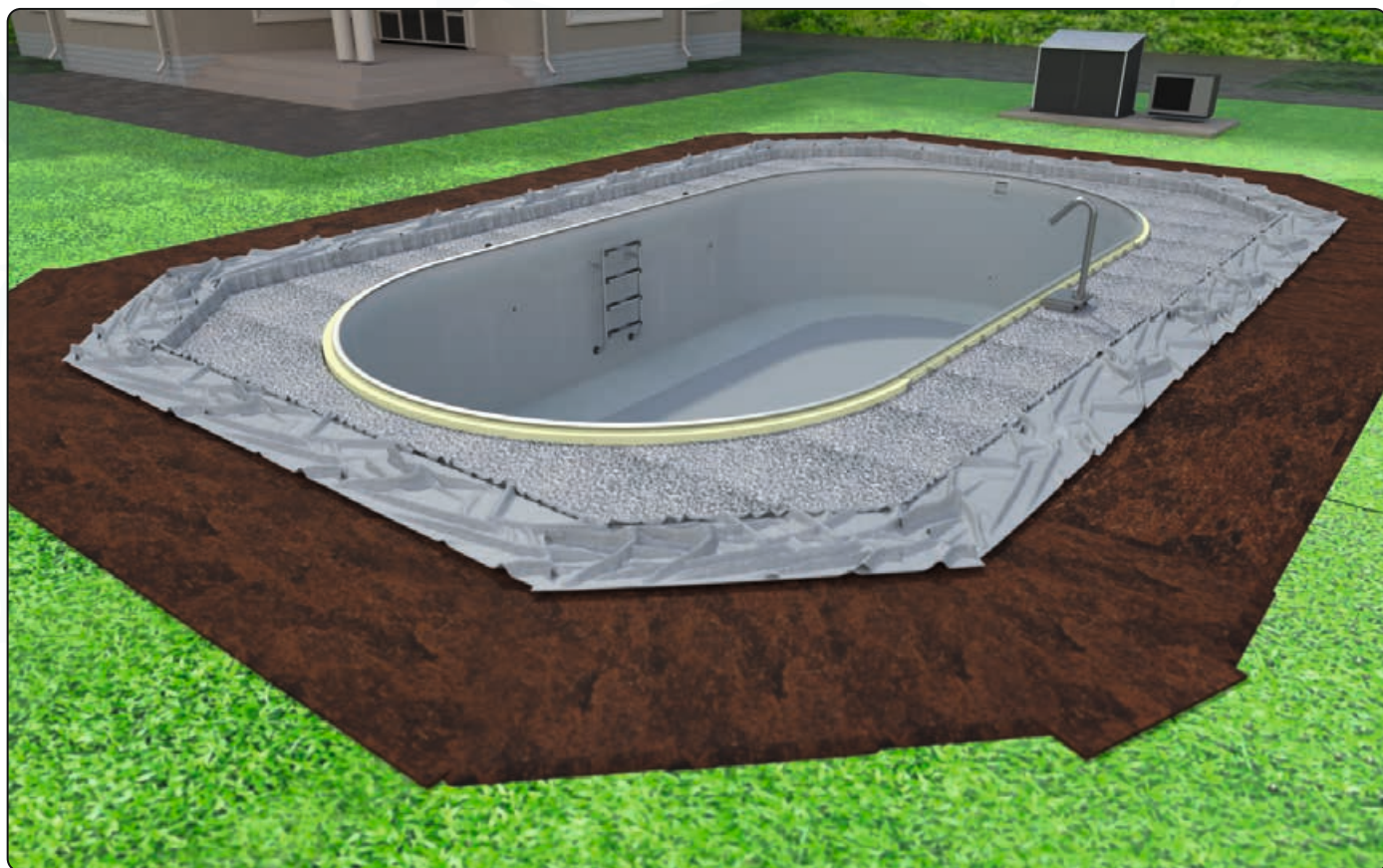
Baugrube gleichmäßig mit Kies aufgefüllt
