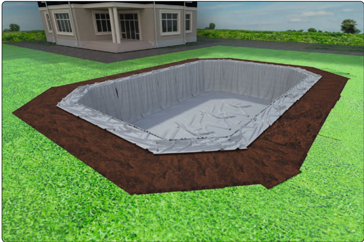
Geotextvlies vollflächig ausgelegt
