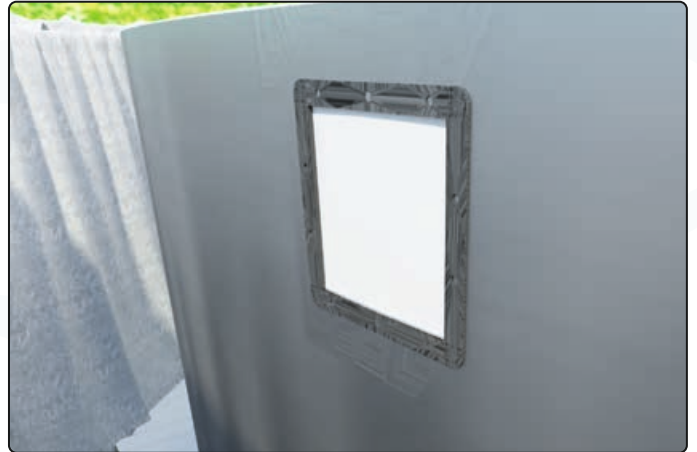
Doppeldichtung auf die Rückseite der Skimmeröffnung stecken
