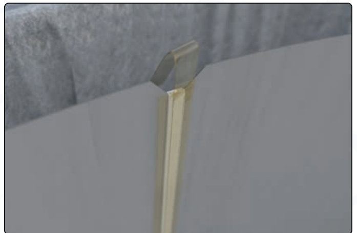
Scharfe Kanten mit Klebeband abkleben
