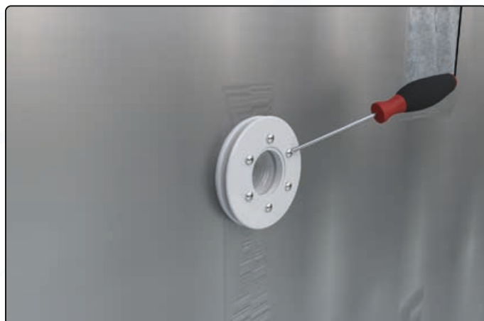
Schrauben Sie den Flansch auf den Grundkörper
