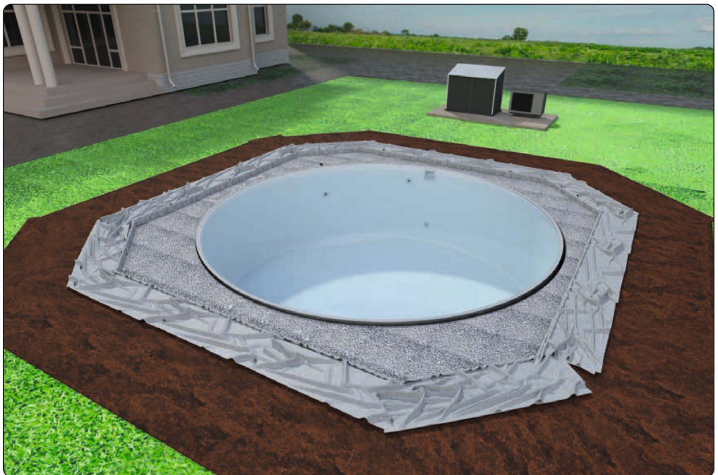
Baugrube gleichmäßig mit Kies aufgefüllt
