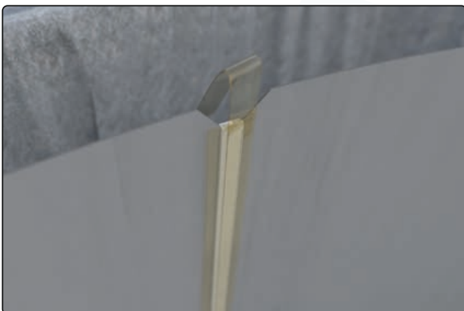
Scharfe Kante mit Klebeband abkleben
