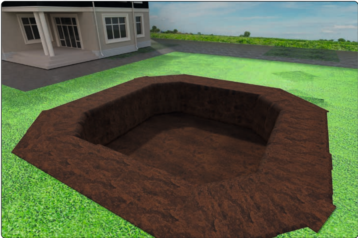
Die Baugrube wurde ausgehoben, der Untergrund ist bereits tragfähig
