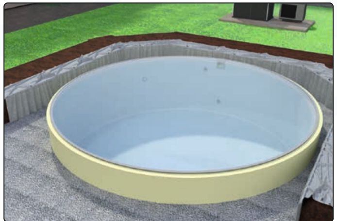
Kies gleichmäßig in der Baugrube einbringen
