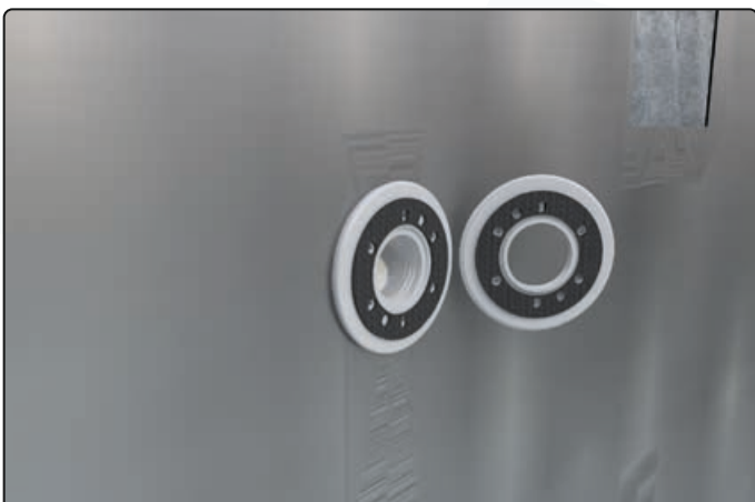
Kleben Sie die Dichtungsscheiben auf
