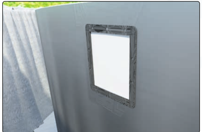
Doppeldichtung auf die Rückseite der Skimmeröffnung stecken
