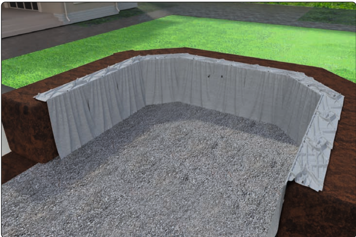
Falls erforderlich: Baugrube mit zusätzlicher Schotter- und Geotextilschicht ausgekleidet
