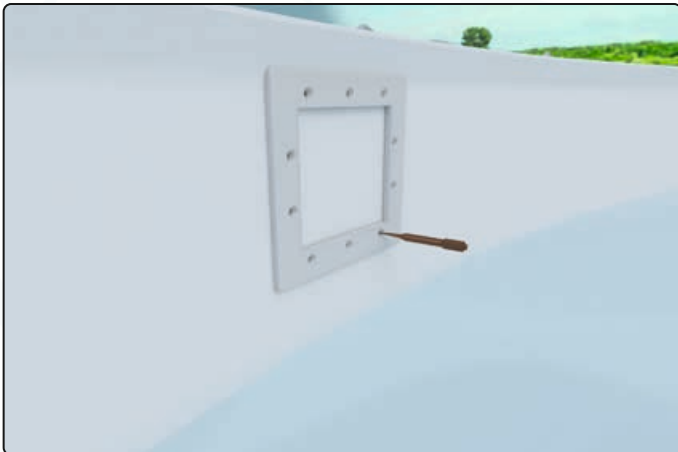
Lochbild nach dem Innenflansch anzeichnen und vorstechen
