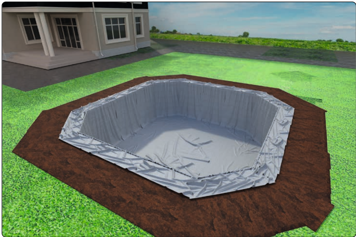
Geotextvlies vollflächig ausgelegt
