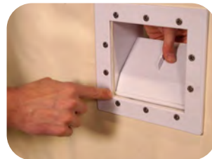
Skimmerklappe montieren
