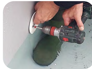
Flanschplatte anschrauben
