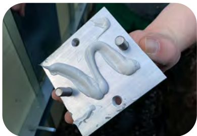
Schrauben mit Flanschplatte an die Stahlwand kleben
