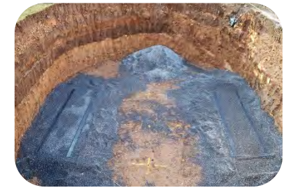
Vierkantrohre fertig platziert
