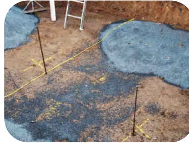
Mittelachse markieren
