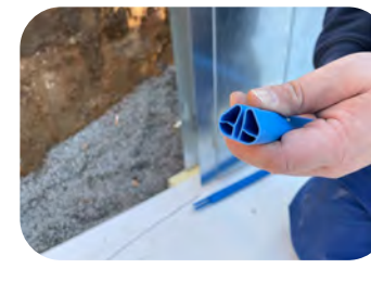
Bodenschiene ohne Verbinder
