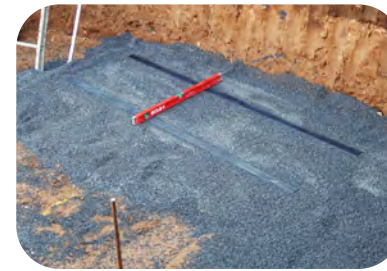
Splitt zwischen Vierkantrohren plan abziehen
