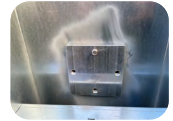
Flanschplatte probeweise anschrauben
