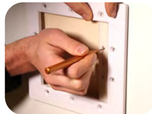
Lochbild stechen Flansch als Vorlage
