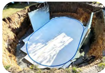
Fertig verlegte Bodenschiene
