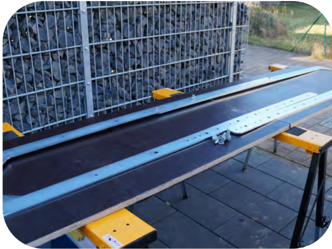
Zugstreben außerhalb der Baugrube vormontieren
