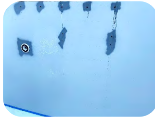
Löcher bohren und verzinken
