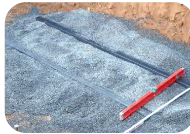
Splitt zwischen Vierkantrohre geben
