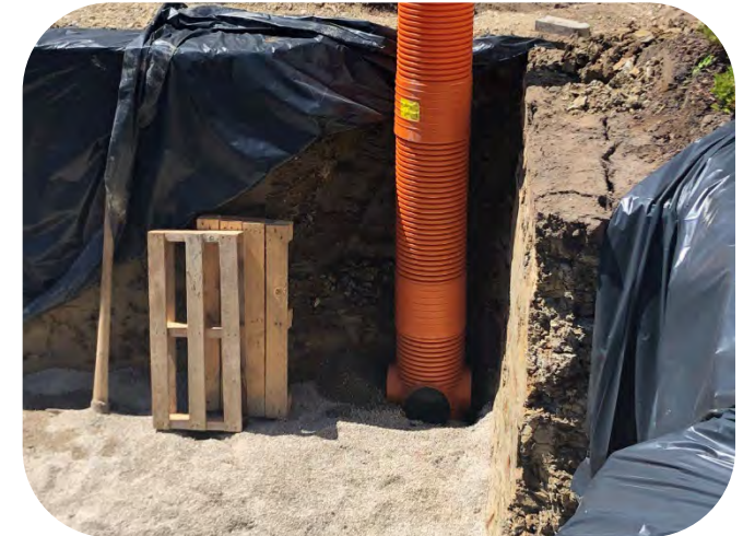
Kontrollschacht für Grundwasser
