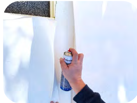
beiligenden Sprühkleber verwenden
