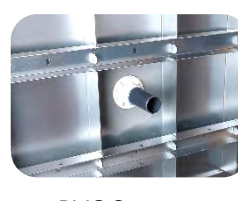
PVC Stützen einkleben
