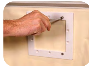
Innenflansch montieren
