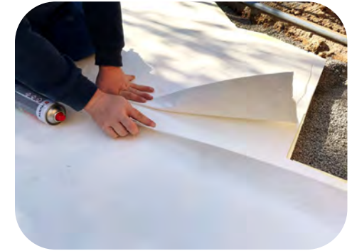
Stöße und Randbereich verkleben
