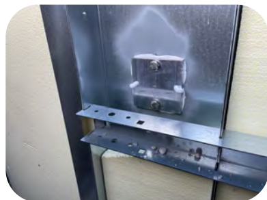
Flanschplatte aufgeklebt
