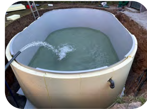
Dämmung kpl. angebracht
