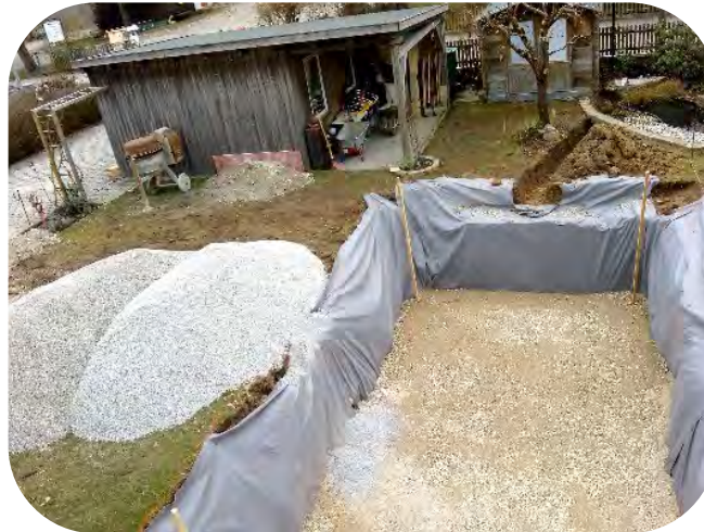
Ausgeschachtete Baugrube
