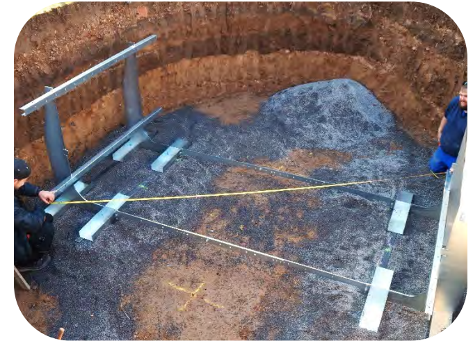
Rechtwinkligkeit messen (Diagonale unterer Querträger)
