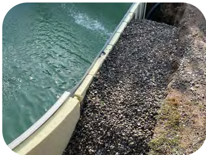
Kies parallel zum Wasserstand aufgefüllt
