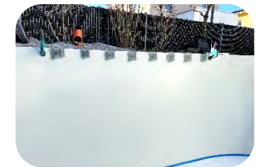
Stahlwand verschraubt oder genietet und verzinkt
