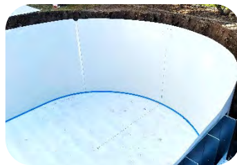
Verbindungsschiene einschieben bis auf Bodenschiene
