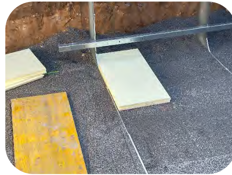
Bodenplatten auslegen
