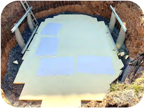
Vinylplatten auslegen (Versatz)
