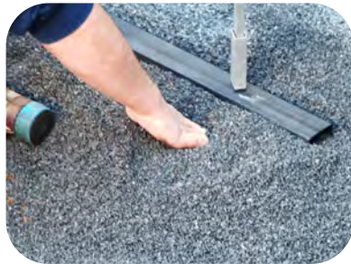
Vierkantrohr auf Höhe bringen. Splitt unter Vierkantrohr stopfen
