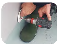
Flanschplatte anschrauben
