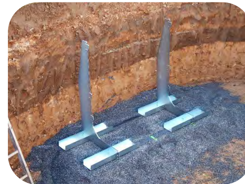
L-Träger grob positioniert
