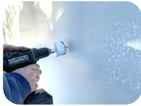
Bohren \varnothing 61 - 65
