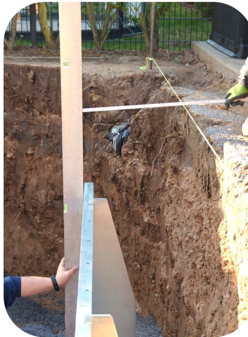
Stützwand zu Bezugspunkt ausrichten
