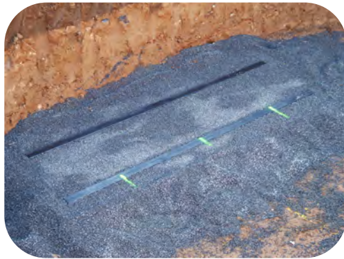
L-Träger position gekennzeichnet
