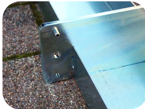
Nasen vollständig eingeklinkt
