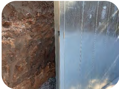
Abschlussprofile anschrauben / nieten
