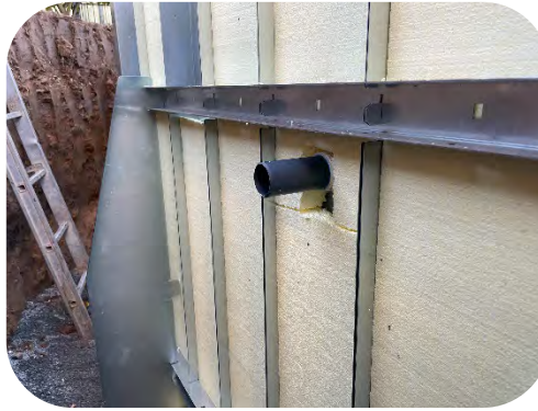
Einbauteile aussparen
