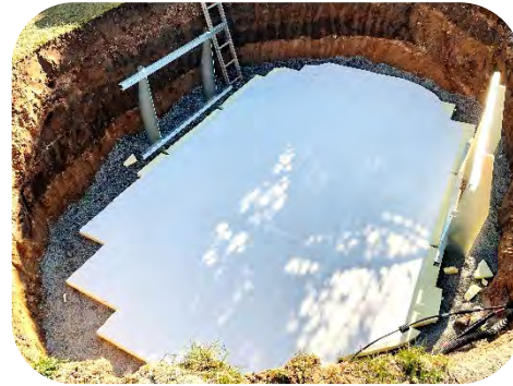
Vinylplatten mit beiligendem Klebeband verkleben
