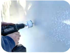
Bohren \varnothing 61 - 65
