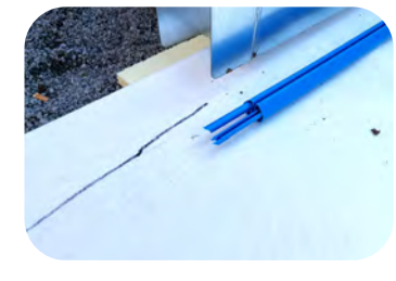
Bodenschiene mit Verbinder
