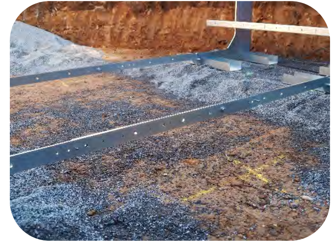
Zugstrebe an L-Träger montiert
