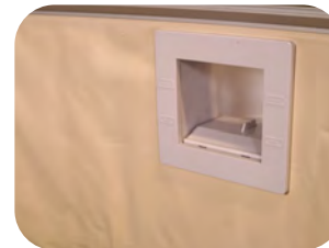
Fertig montierter Skimmer
