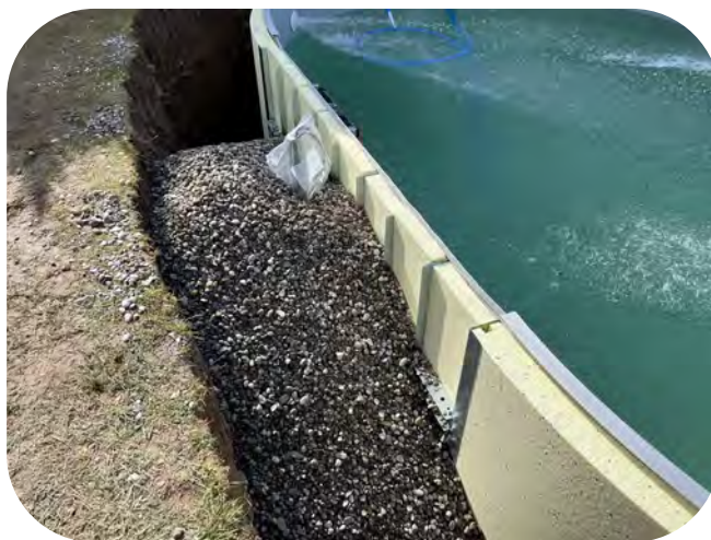
Lampenauslass mit Folie geschützt
