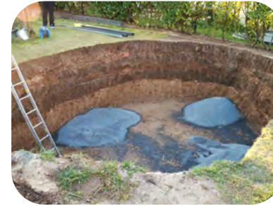
Splitt im Bereich Vierkantrohre ausbringen
