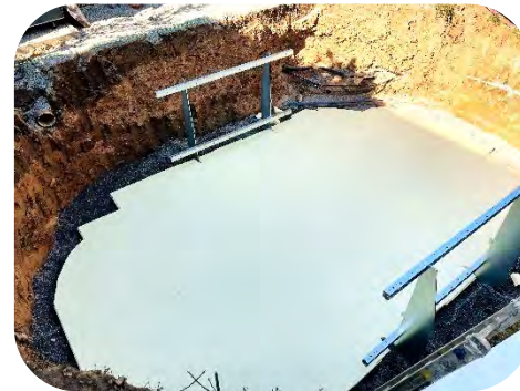
Bodenplatten fertig verlegt
