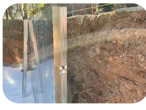
Abschlussprofil montiert
