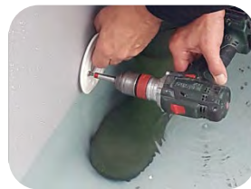
Flanschplatte anschrauben
