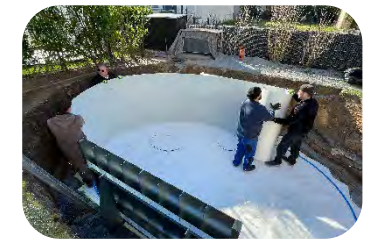
In die Bodenschiene stellen
