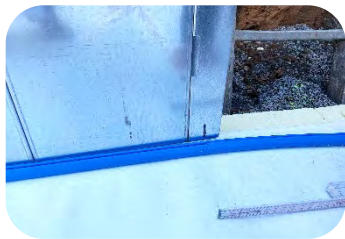
Bodenschiene zusammenstecken
