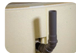
HT-Rohr aufstecken
