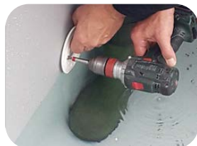
Flanschplatte anschrauben
