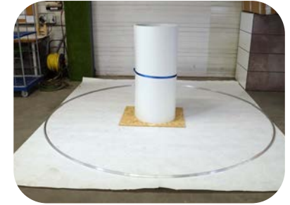
Stahlwand platzieren
