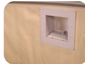
Fertig montierter Skimmer
