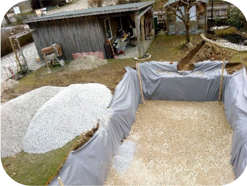
Ausgeschachtete Baugrube
