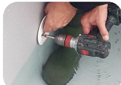
Flanschplatte anschrauben
