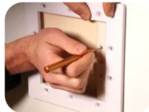
Lochbild stechen Flansch als Vorlage
