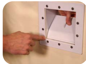
Skimmerklappe montieren
