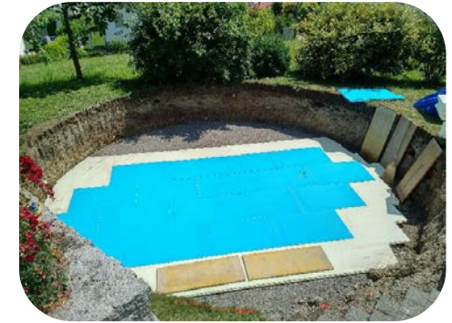
Vinylplatten auslegen / verkleben
