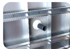
PVC Stützen einkleben
