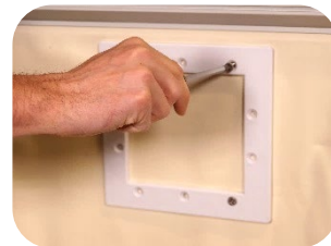
Innenflansch montieren
