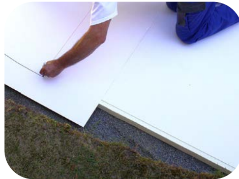
Vinylplatten zurecht schneiden
