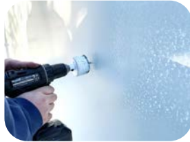
Bohren ø61 - 65
