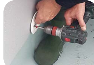
Flanschplatte anschrauben
