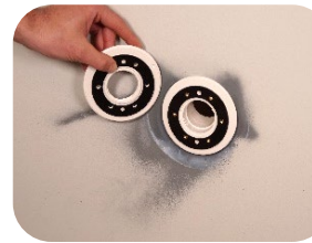
Dichtung auf Dichtung stecken
