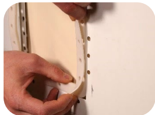
Doppeldichtung aufstecken
