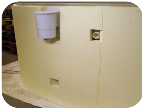
Einbauteile aussparen
