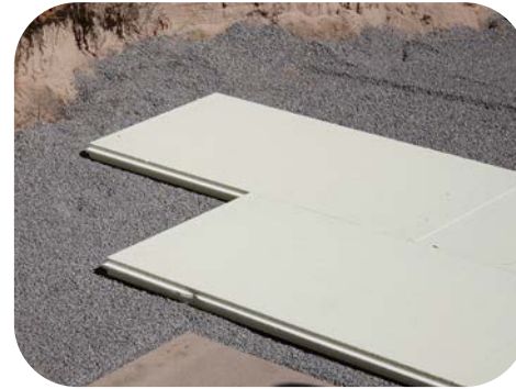
Bodenplatten auslegen
