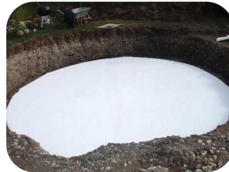
Vlies auf Vinylplatten auslegen
