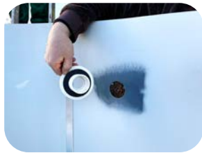
Körper in die Stahlwand
