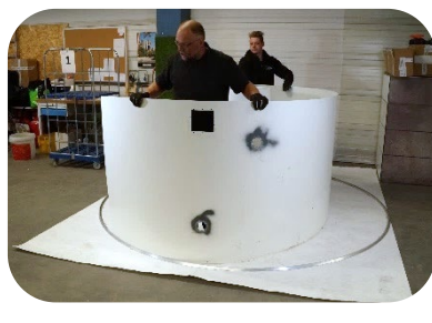
Stahlwand in Bodenschiene stecken
