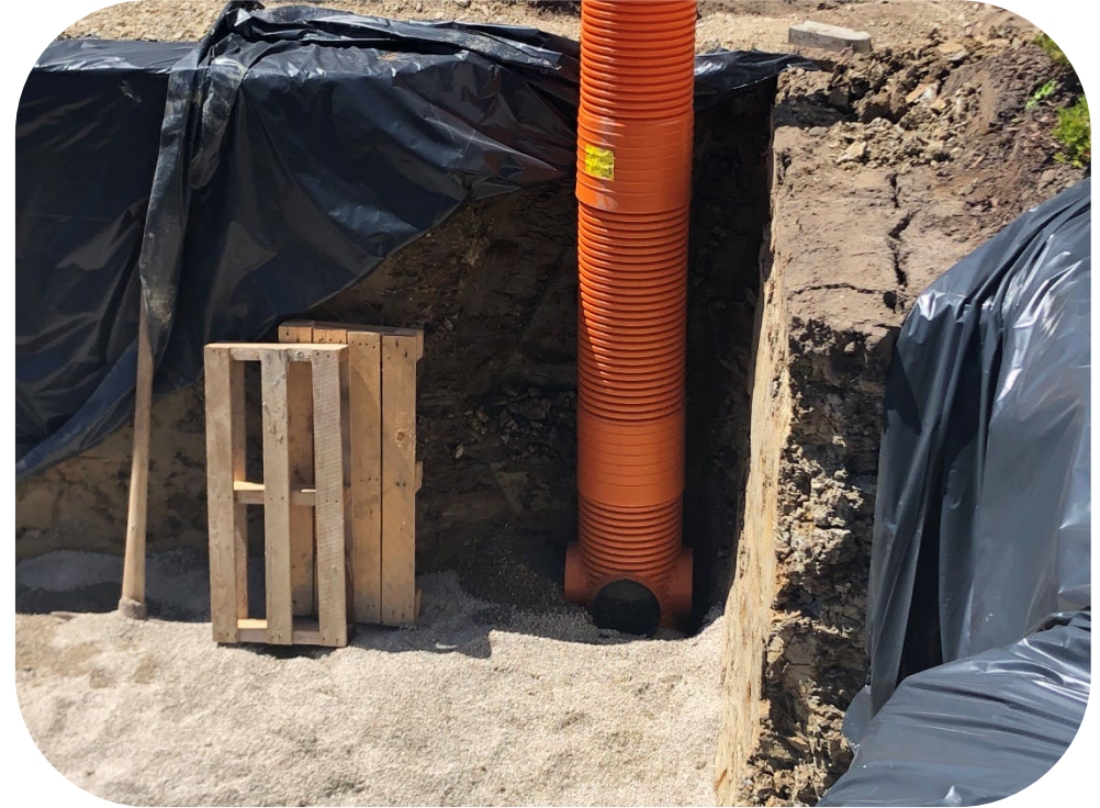
Kontrollschacht für Grundwasser
