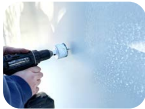
Bohren \varnothing 61 - 65
