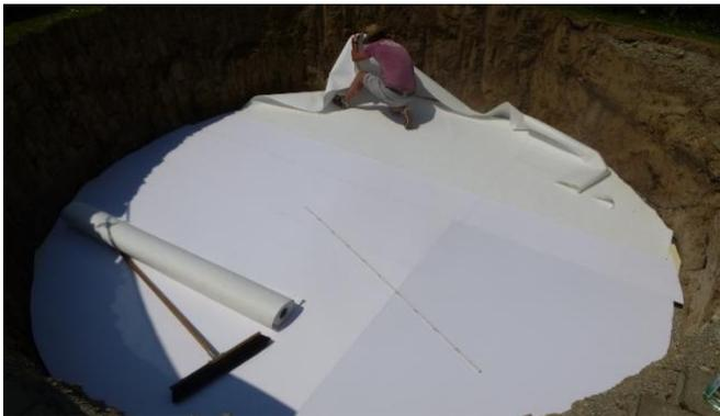
Das schutzimprägnierte Bodenvlies auf der Bodenplatte verlegen und zuschneiden.
