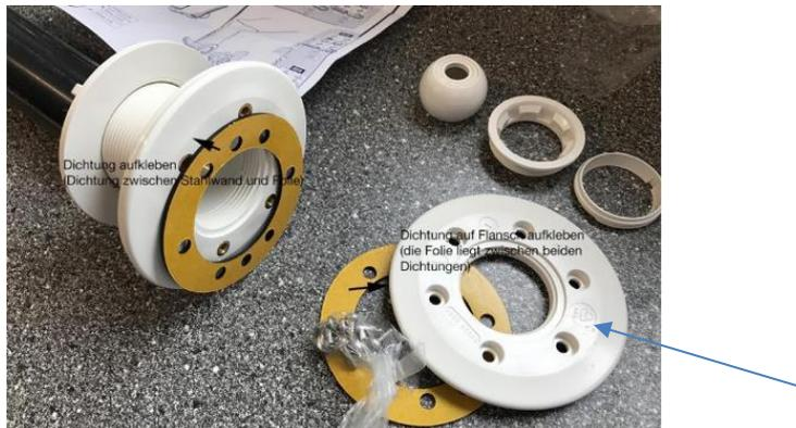
Sobald der Wasserstand knapp unter dem ersten Einbauteil steht, kann der Innenflansch der Düse mit der aufgeklebten Dichtung, mit der bereits montierten Multiflow Düse verschraubt durch die Folie verschraubt werden. Die Gewindebohrungen der Düse werden dazu mit dem Finger ertastet.
