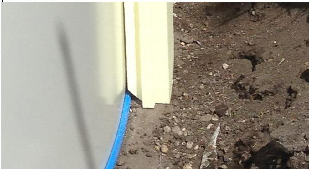
Durch Fertigungstoleranzen des Materials und Schwankungen der Luftfeuchtigkeit während der Lagerung kann es vorkommen, dass sich ein Spalt von wenigen Zentimetern nicht ganz schließen lässt. Diesen Spalt kann man dadurch schließen, indem bei einigen Rundschalungselementen die Feder nicht vollständig in die Nut gesteckt wird. Alternativ kann der Spalt auch mit Bauschaum geschlossen werden.
