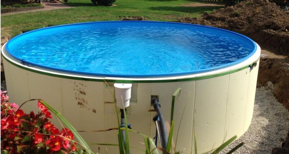
Die Verrohrung von Skimmer und Düsen gemäß Verrohungsplan für das entsprechende Becken (siehe oben) kann jetzt abgeschlossen werden. Die Rundschalung wird an den entsprechenden Stellen ausgeschnitten.
